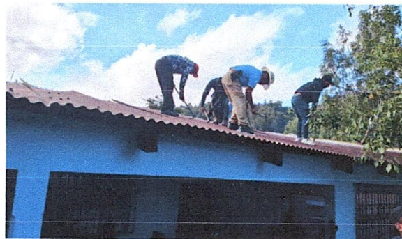
Foto 2: Desmontaje del techo.
