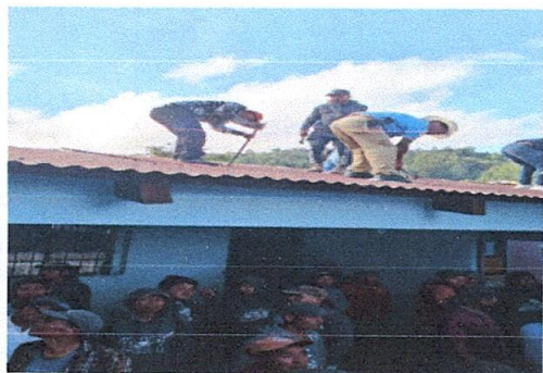
Foto1: Desmontaje del techo
