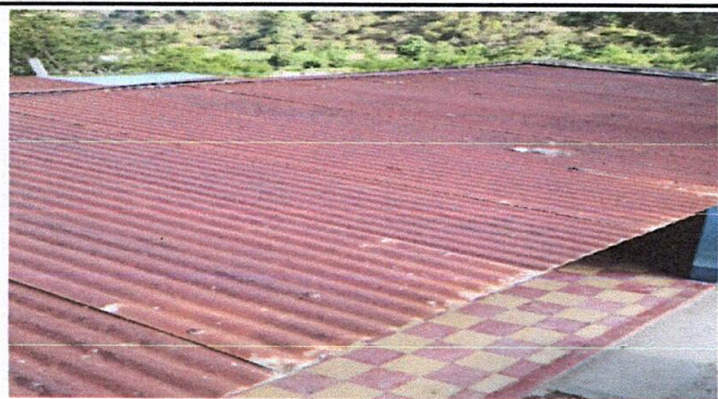
Foto1: Sustitución de lámina en mal estado
