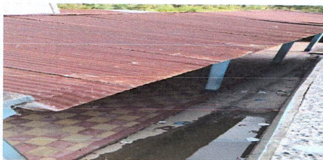
Foto 5: Sustitución de canal de agua
