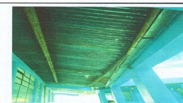
Foto 6: Sustrucción de estructura portante de madera por metal
