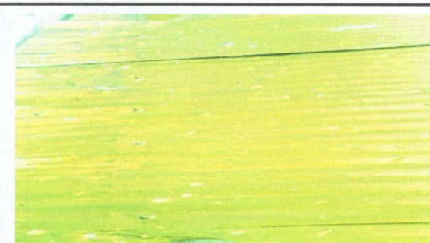
Foto 4: Sustrucción de lámina en mal estado
