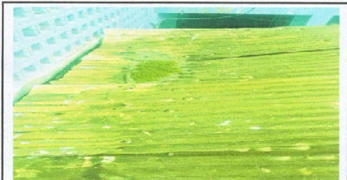
Foto 3: Sustrucción de lámina en mal estado
