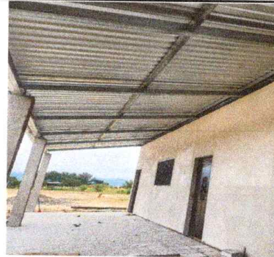
Foto 2: Sustitución de estructura de soporte de techo
