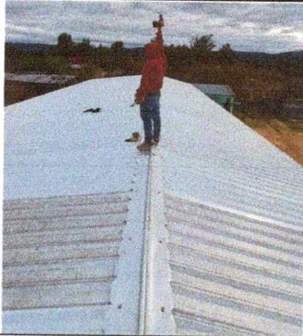
Foto1: Sustitución de lámina por lámina troquelada
