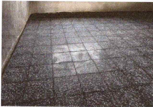
Foto 5: Sustitución de piso de torta por granito
