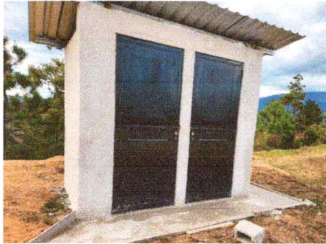
Foto 7: Mantenimiento a estructura de servicios sanitarios
