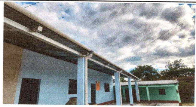
Foto 6: Mejoramiento de bajadas de agua pluvial
