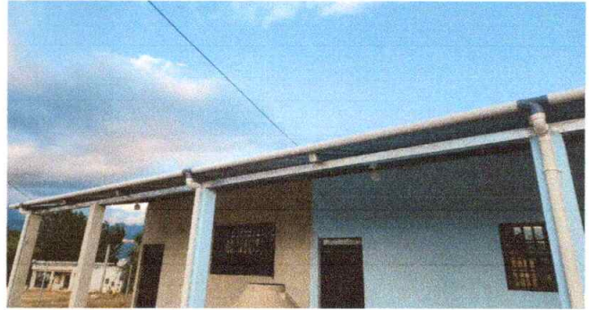
Foto 8: Reparación de cableado eléctrico
