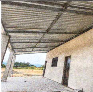
Foto 9: Mano de obra para techo con estructura de tubo galvanizado y lámina troquelada
