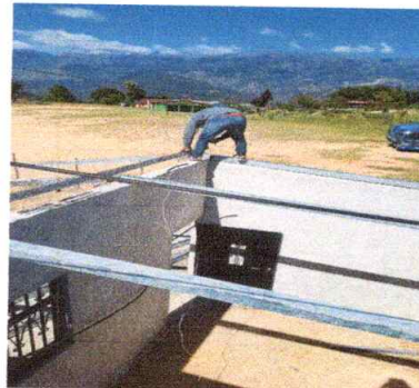
Foto 2: Sustitución de estructura de soporte de techo
