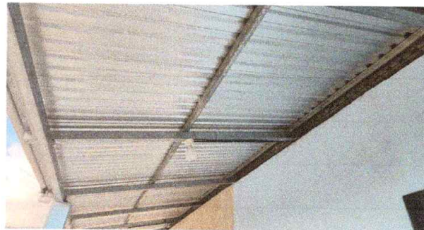
Foto 8: Reparación de cableado eléctrico
