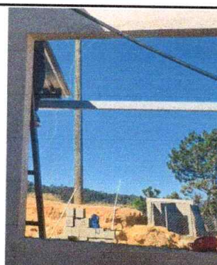
Foto 4: Sustitución de ventanas de madera por metal
