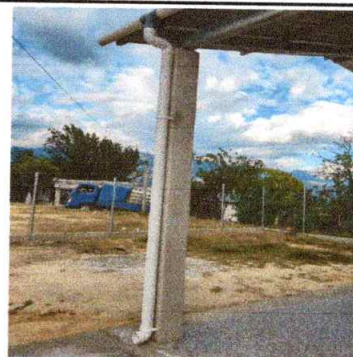
Foto 6: Mejoramiento de bajadas de agua pluvial
