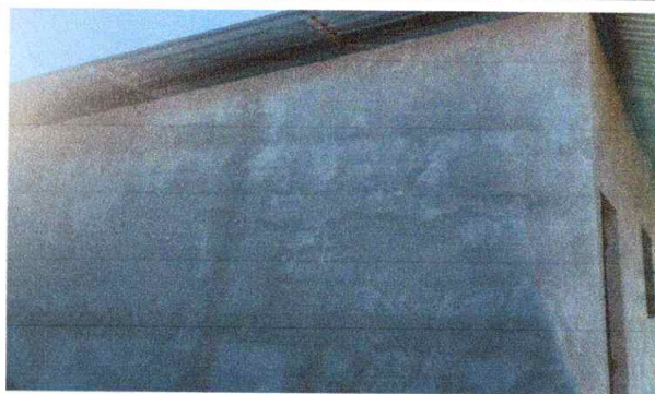
Foto 10: Reparación de repello y cernido de paredes
