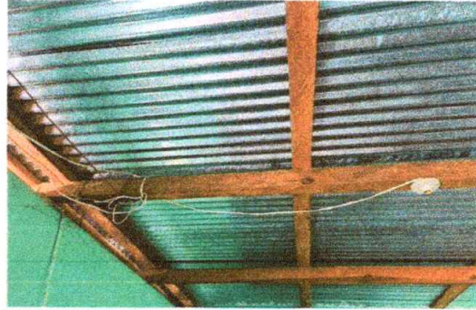
Foto 8: Reparación de cableado eléctrico
