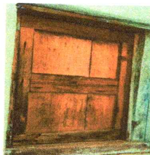
Foto 4: Sustitución de ventanas de madera por metal
