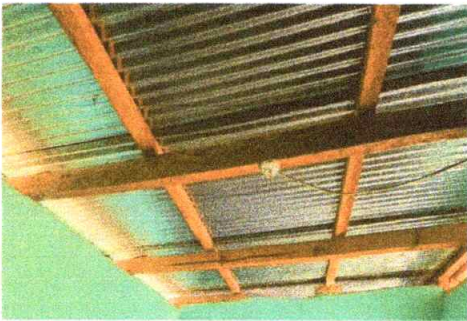
Foto 9: Mano de obra para techo con estructura de tubo galvanizado y lámina troquelada
