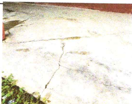
Foto 5: Sustitución de piso de torta por granito
