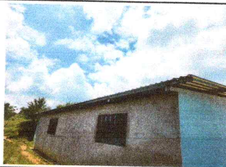
Foto 6: Mejoramiento de bajadas de agua pluvial
