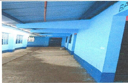
Foto 8: Pintura en muros exteriores e interiores
