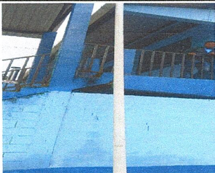
Foto 7: Reparación de bajada de agua pluvial, tubo PVC 3"
