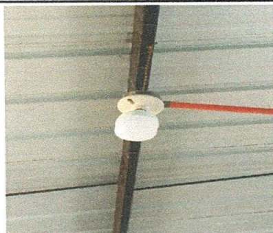
Foto 11: Sustitución de focos ahorradores
