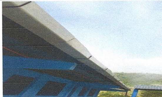
Foto 6: Sustrucción de canal de pvc
