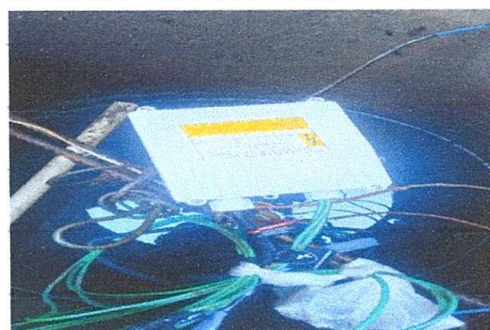
Foto 10: Sustitución de bomba de agua
