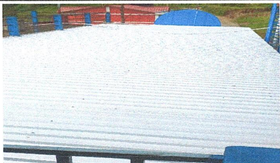
Foto 1: Sustrucción de lámina
