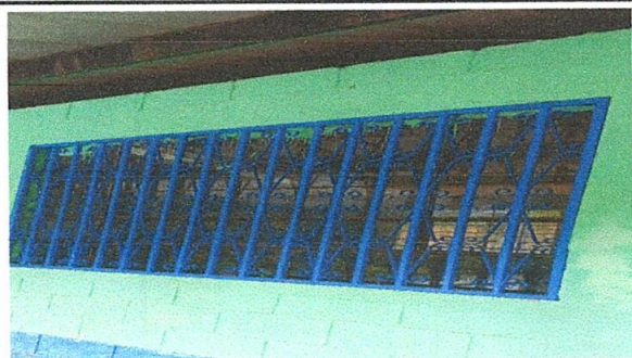
Foto 5: Sustrucción de balcones de metal
