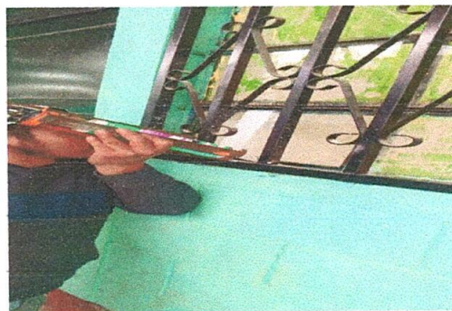
Foto 4: Sustitución de vidrios
