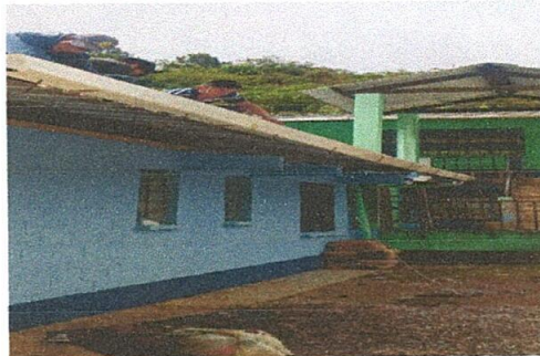
Foto 6: Sustitución de canal de pvc
