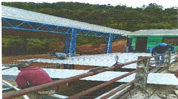
Foto 1: Sustitución de lámina
