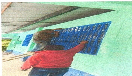
Foto 5: Sustitución de balcones de metal
