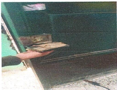
Foto 3: Sustitución de chapa
