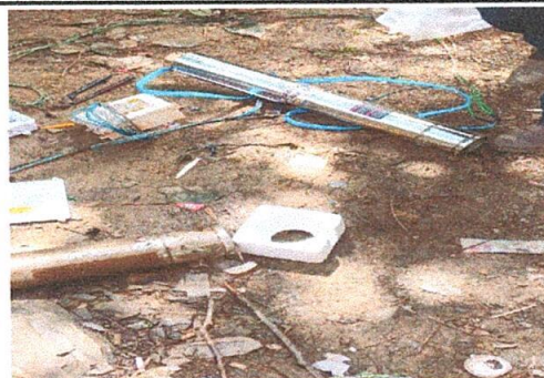
Foto 10: Sustitución de bomba de agua
