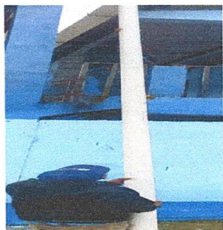
Foto 7: Reparación de bajada de agua pluvial, tubo PVC 3"
