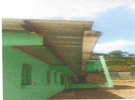
Foto 6: Sustitución de canal de pvc
