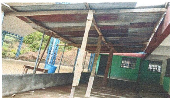
Foto 1: Sustitución de lámina
