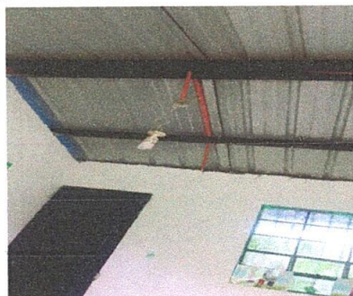
Foto 11: Sustitución de focos ahorradores
