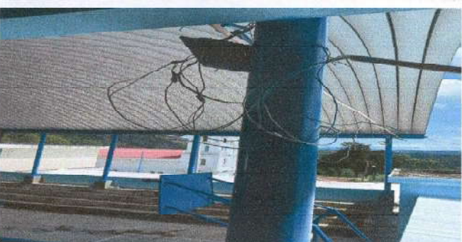
Foto 11: Instalación de lamparas para cancha polideportiva y cambio de cable
