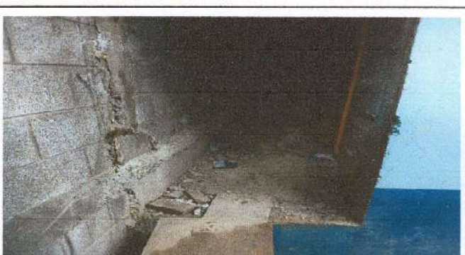
Foto 10: Instalación nuevo servicio sanitario
