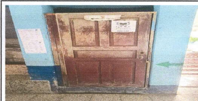
Foto 15: Sustitución de puertas de bodega
