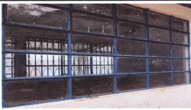
Foto 2: Mantenimiento a estructura de metal de ventana
