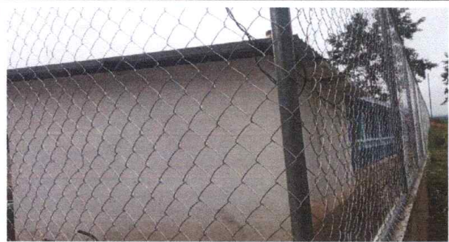
Foto 9: Reparación de tubo hg y malla galvanizada
