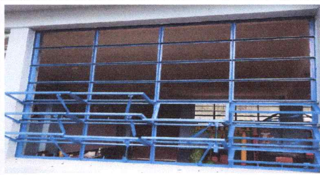
Foto 4: Sustitución de vidrios
