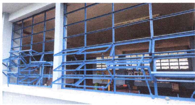
Foto 3: Sustitución de estructura de metal de ventana
