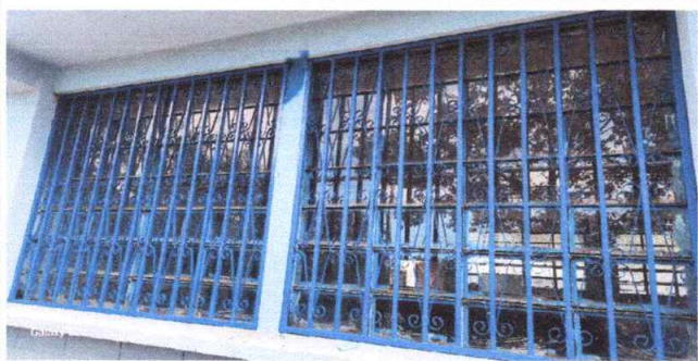
Foto 5: Sustitución de balcones de metal
