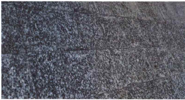
Foto 7: Sustrución de piso de granito
