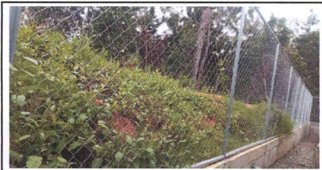
Foto 12: Reparación de tubo hg y malla galvanizada
