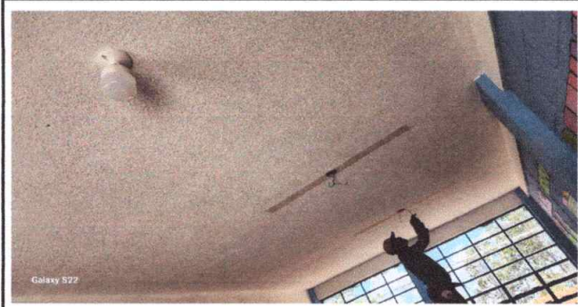
Foto 10: Sustrución de lamparas tipo LED
