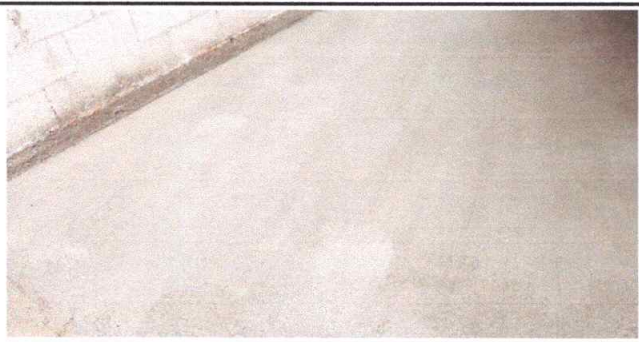
Foto 11: Sustrución de piso de torta de concreto
