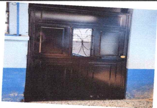
Foto 1: Sustitución de puerta (260 cms. de alto * 90 cms. de ancho)
