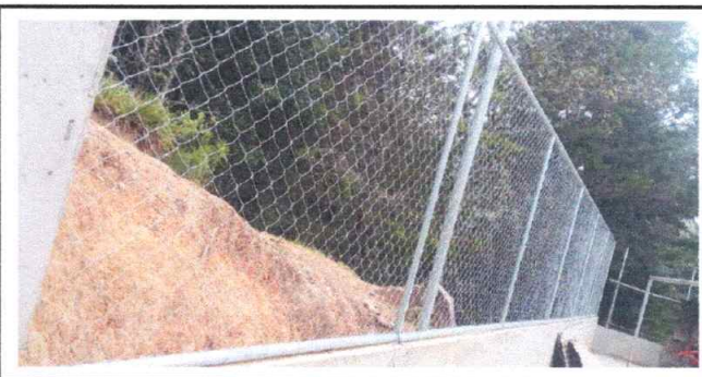
Foto 12: Reparación de tubo hg y malla galvanizada
