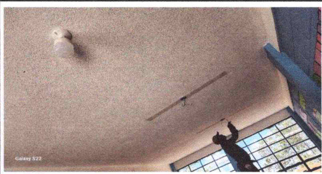
Foto 10: Sustitución de lamparas tipo LED
