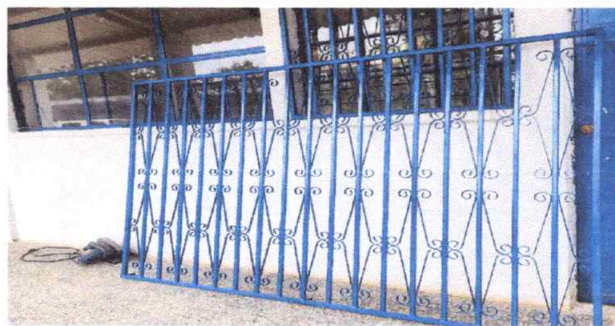
Foto 5: Sustitución de balcones de metal
