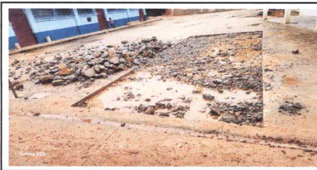
Foto 11: Sustitución de piso de torta de concreto
