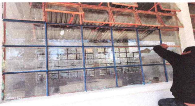
Foto 3: Sustitución de estructura de metal de ventana
