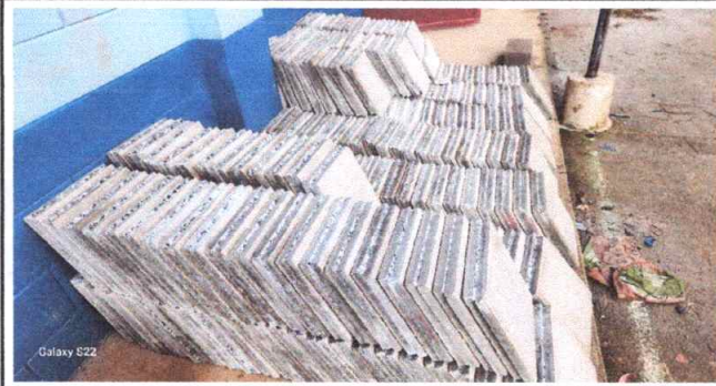
Foto 7: Sustitución de piso de granito
