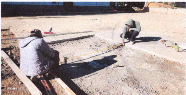
Foto 6: Sustitución de piso de torta de concreto
