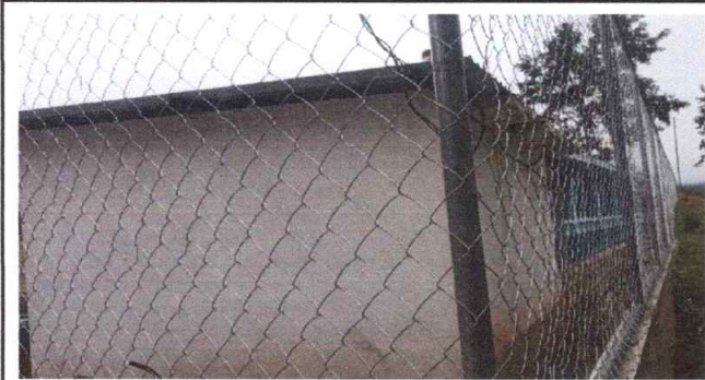
Foto 9: Reparación de tubo hg y malla galvanizada
