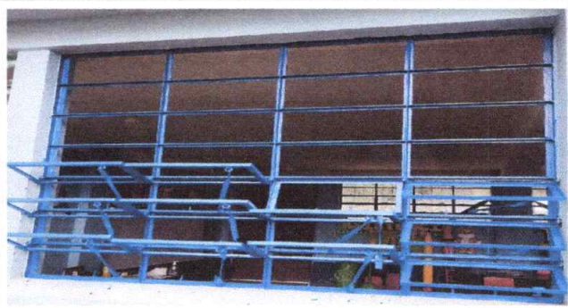
Foto 4: Sustitución de vidrios
