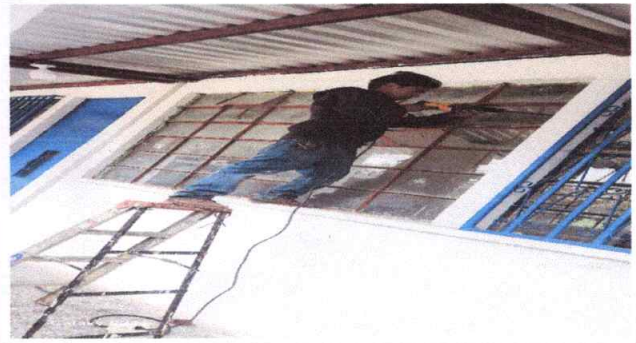
Foto 2: Mantenimiento a estructura de metal de ventana
