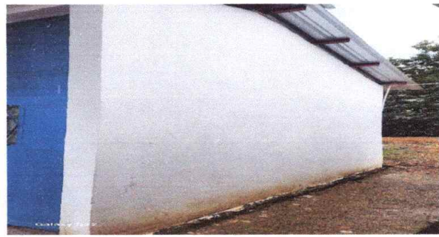
Foto 8: Pintura en muros exteriores e interiores
