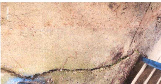
Foto 11: Sustrucción de piso de torta de concreto
