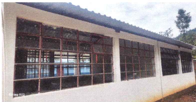
Foto 3: Sustitución de estructura de metal de ventana
