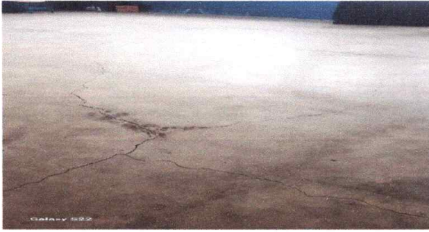
Foto 7: Sustrucción de piso de granito
