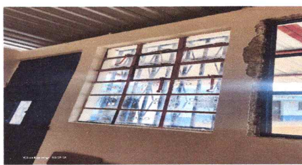
Foto 2: Mantenimiento a estructura de metal de ventana
