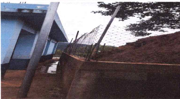
Foto 9: Reparación de tubo hg y malla galvanizada
