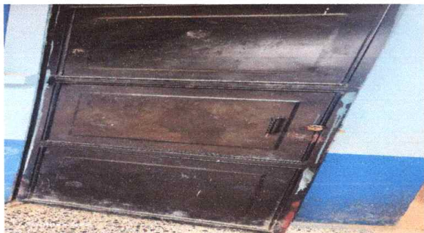
Foto 1: Sustitución de puerta (260 cms. de alto * 90 cms. de ancho)
