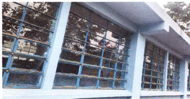
Foto 4: Sustitución de vidrios
