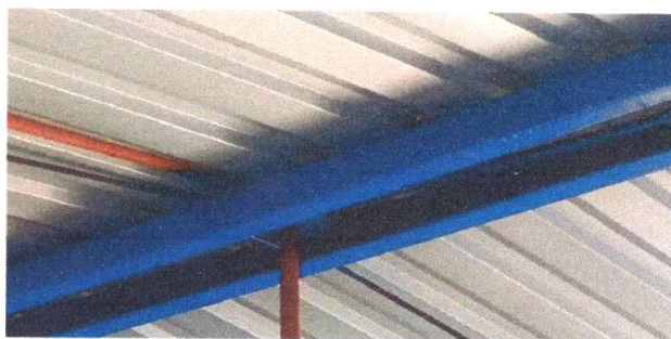
Foto 4: Mantenimiento a estructura de soporte de metal
