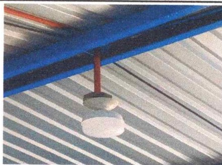
Foto 12: Sustrucción de lamparas tipo LED
