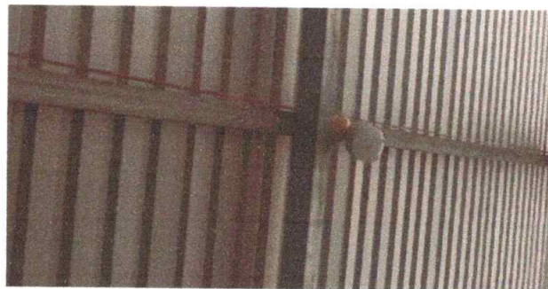
Foto 14: Reparación de cableado eléctrico
