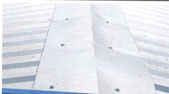
Foto 3: Sustitución de elementos de fijación
