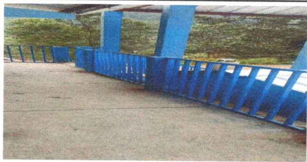
Foto 11: Mantenimiento a barandas de metal
