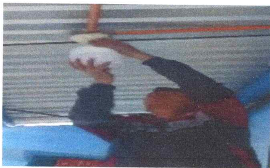
Foto 13: Sustitución de plafoneras
