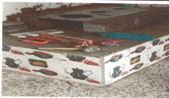
Foto 17: Instalación de azulejo en estufa rural
