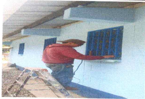
Foto 7: Sustitución de balcones de metal
