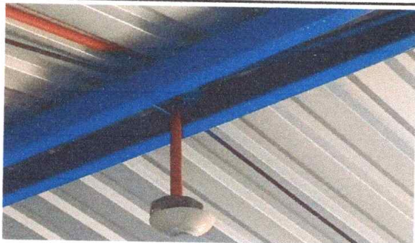
Foto 13: Sustrucción de plafoneras
