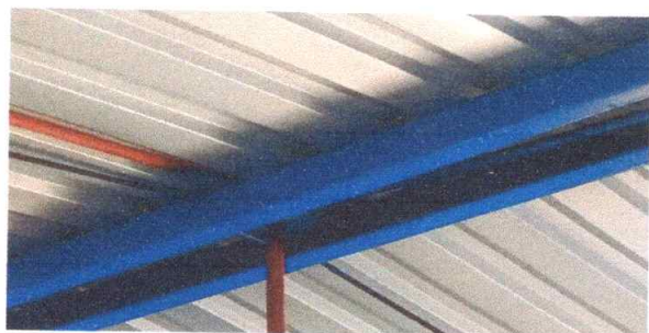
Foto 3: Sustitución de elementos de fijacion
