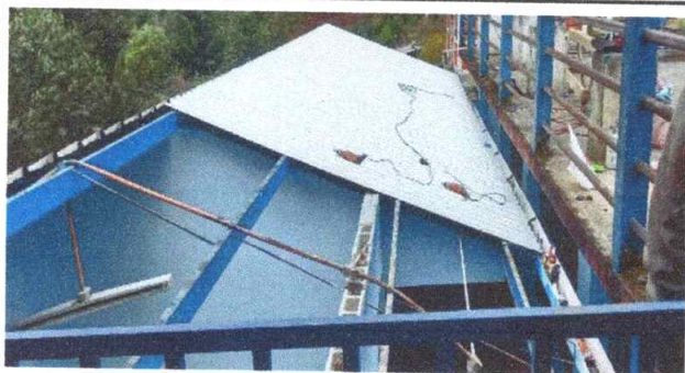
Foto 15: Instalación de lámina troquelada aluzinc
