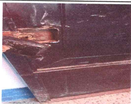
Foto 5: Sustitución de chapa
