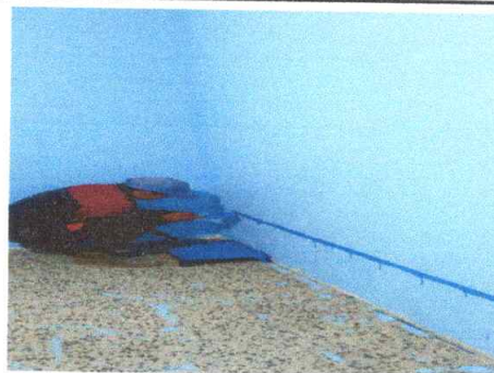
Foto 10: Pintura en muros exteriores e interiores
