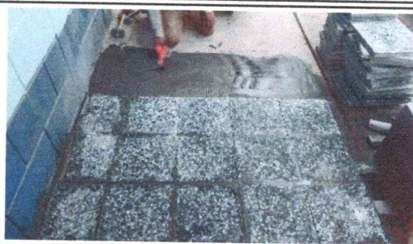
Foto8 : Sustitución de piso de granito
