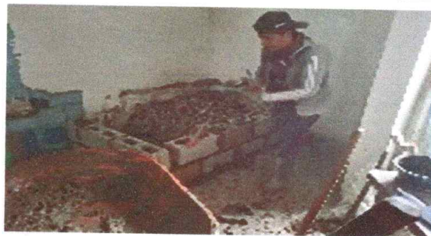
Foto 16: Sustrucción de estufa rural (completa) incluye chimenea y plancha de metal
