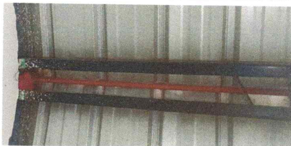
Foto 4: Mantenimiento a estructura de soporte de metal
