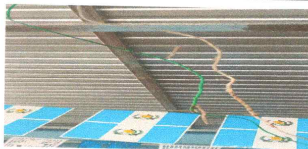
Foto 14: Reparación de cableado eléctrico
