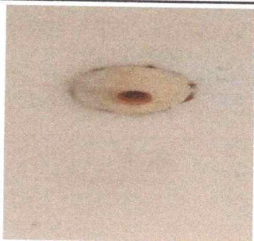
Foto 13: Sustitución de plafoneras
