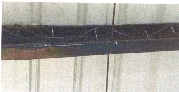
Foto 3: Sustitución de elementos de fijación
