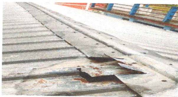
Foto 15: Instalación de lámina troquelada aluzinc
