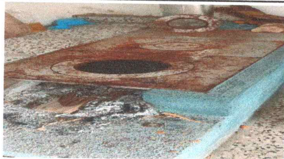
Foto 17 :Instalación de azulejo en estufa rural
