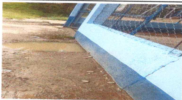
Foto 9: Reparación de cuneta de concreto
