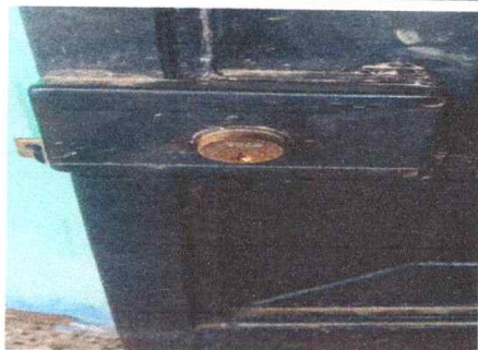
Foto 5: Sustitución de chapa
