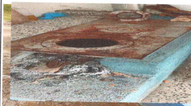
Foto 16: Sustitución de estufa rural (completa) incluye chimenea y plancha de metal
