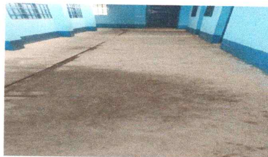
Foto8 : Sustitución de piso de granito
