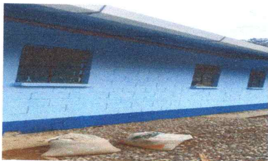
Foto 7: Sustitución de balcones de metal
