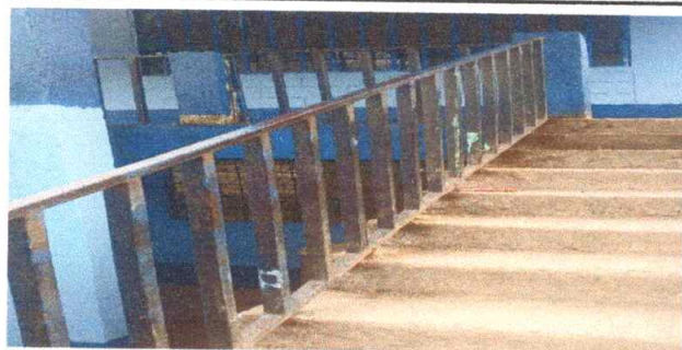
Foto11: Mantenimiento a barandas de metal
