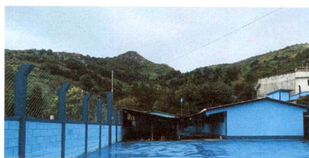
Foto 6: PINTURA EN MUROS EXTERIORES E INTERIORES
