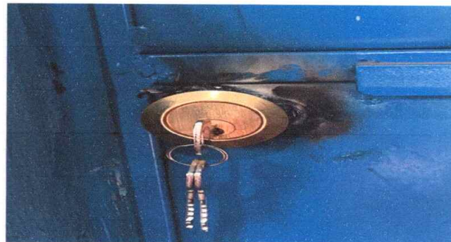
Foto 2: SUSTITUCIÓN DE CHAPA
