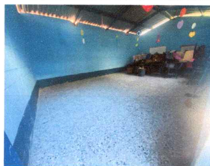
Foto 4: SUSTITUCIÓN DE PISO TORTA DE CONCRETO AULA
