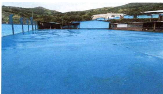
Foto 5: SUSTITUCIÓN DE PISO TORTA DE CONCRETO PATIO
