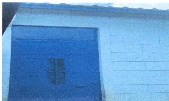
Foto 3: SUSTITUCIÓN DE DE PUERTA (2.10m de alto * 1.00m de ancho)
