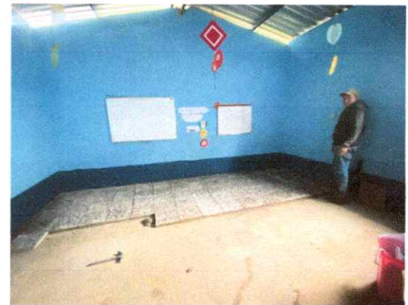
Foto 4: STITUCIÓN DE PISO TORTA DE CONCRETO AULA
