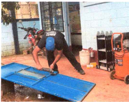
Foto 3: SUSTITUCIÓN DE DE PUERTA (2.10m de alto * 1.00m de ancho)
