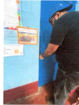
Foto 2: SUSTITUCIÓN DE CHAPA
