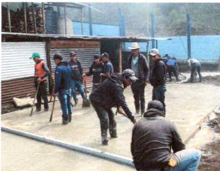
Foto 5: SUSTITUCIÓN DE PISO TORTA DE CONCRETO PATIO
