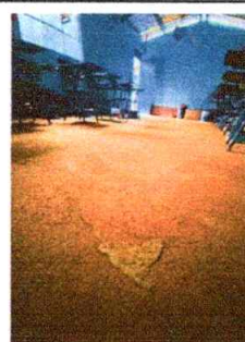
Foto 4: SUSTITUCIÓN DE PISO DE GRANITO AULA
