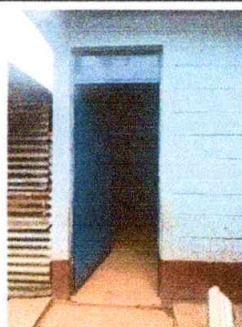
Foto 3: SUSTITUCIÓN DE DE PUERTA (2.10m de alto * 1.00m de ancho)
