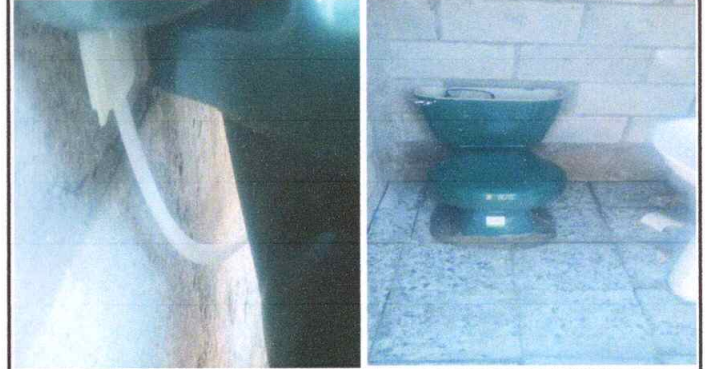
Foto 8: SUSTITUCION DE INODOROS
