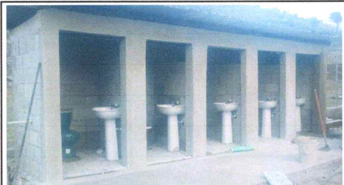
Foto 9: SUSTITUCIÓN DE LAVAMANOS
