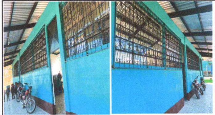
Foto 2: SUSTITUCIÓN DE BALCONES DE METAL 1.90mx1.55m (1 balcon), 2.32mx1.55m (2 balcon), 2.29mx1.55m (1 balcon), 2.30mx1.55m (1 balcon), 2.31mx1.55m (1 balcon)
