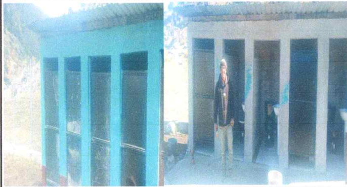
Foto 7: MANTENIMIENTO DE ESTRUCTURA, CAMBIO DE TUBOS, CAMBIO DE FOSA SEPTICA, PINTURA
