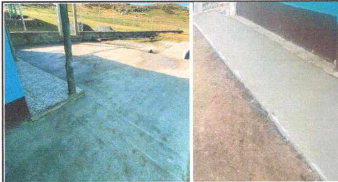
Foto 3: SUSTITUCIÓN DE PISO DE TORTA DE CEMENTO
