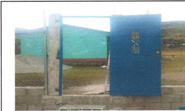
Foto1: SUSTITUCIÓN DE PUERTA (2.10 MTS DE ALTO X 1 MTS DE ANCHO)
