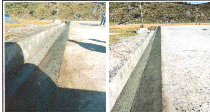
Foto 4: REPARACIÓN DE CUNETA DE CONCRETO
