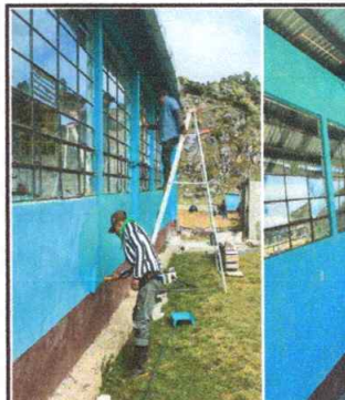
Foto 6: PINTURA EN MUROS EXTERIORES E INTERIORES
