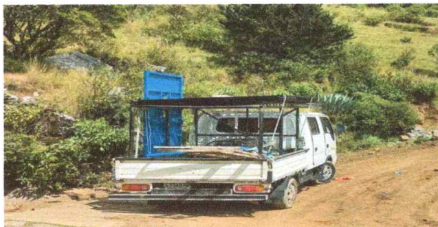
Foto1: SUSTITUCIÓN DE PUERTA (2.10 MTS DE ALTO X 1 MTS DE ANCHO)
