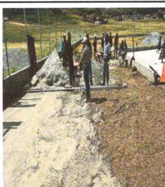
Foto 3: SUSTITUCIÓN DE PISO DE TORTA DE CEMENTO
