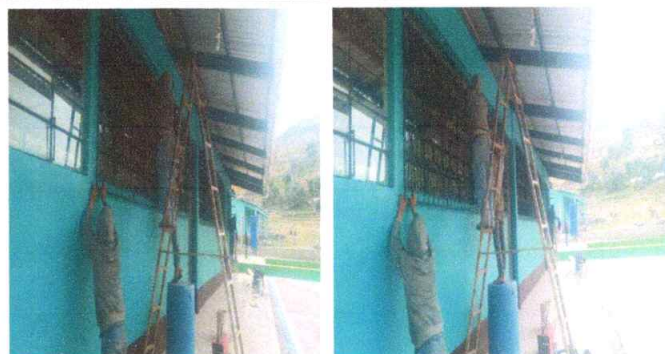
Foto 2: SUSTITUCIÓN DE BALCONES DE METAL 1.90mx1.55m (1 balcon), 2.32mx1.55m (2 balcon), 2.29mx1.55m (1 balcon), 2.30mx1.55m (1 balcon), 2.31mx1.55m (1 balcon)
