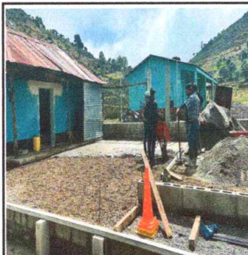
Foto 3: SUSTITUCIÓN DE PISO DE TORTA DE CEMENTO
