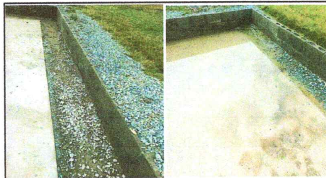
Foto 4: REPARACIÓN DE CUNETAS DE CONCRETO
