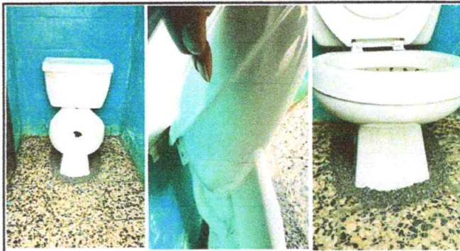
Foto 8: SUSTITUCION DE INODOROS
