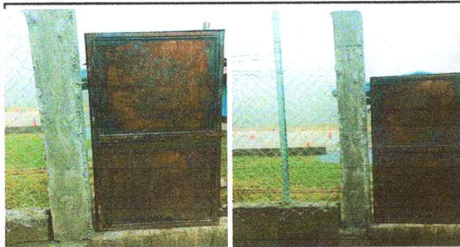
Foto 1: SUSTITUCIÓN DE PUERTA (2.10 MTS DE ALTO X 1 MTS DE ANCHO)
