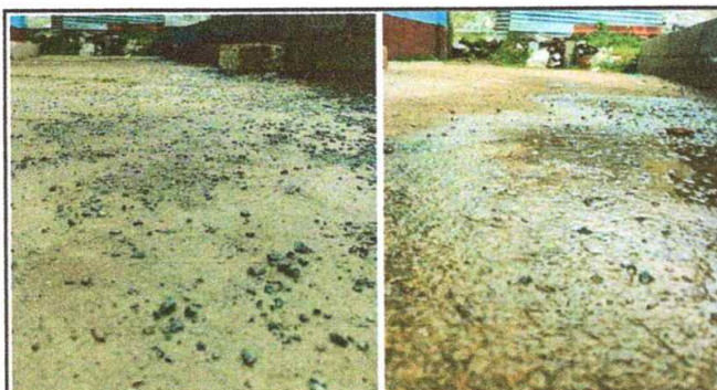
Foto 3: SUSTITUCIÓN DE PISO DE TORTA DE CEMENTO
