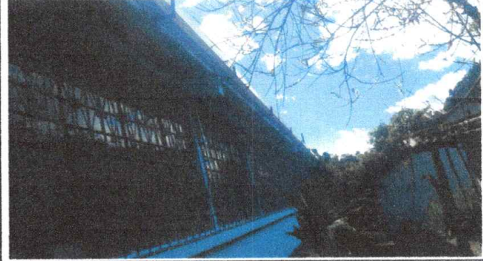
Foto 4: Sustitución de capote de meta, por metal
