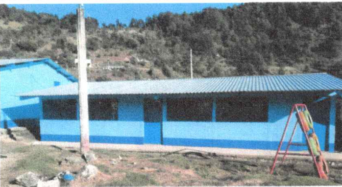
Foto 3: Pintura de muros Exteriores e interiores
