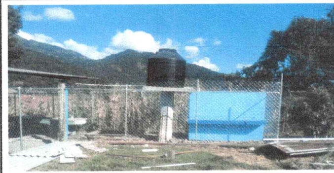
Foto 6: Sustitución de baranda de metal.
