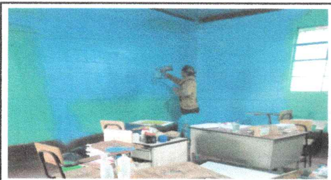
Foto 3: Pintura de muros Exteriores e interiores
