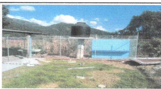
Foto 6: Sustitución de baranda de metal.
