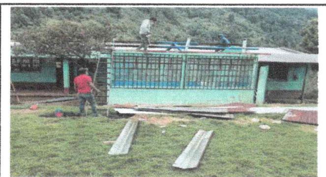
Foto 5: Instalacion de lamina troquelada aluzinc
