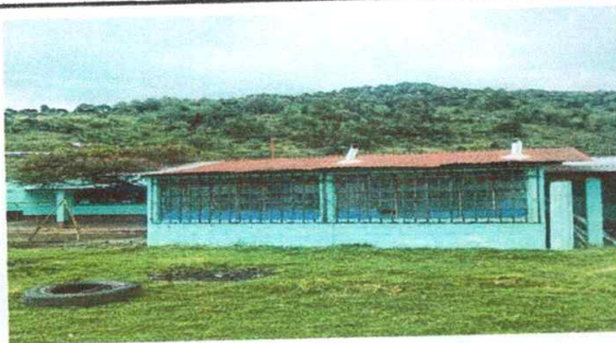
Foto 5: Instalacion de lamina troquelada aluzinc
