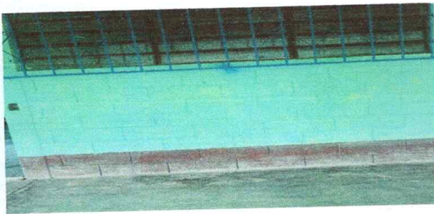
Foto 3: Pintura de muros Exteriores e interiores
