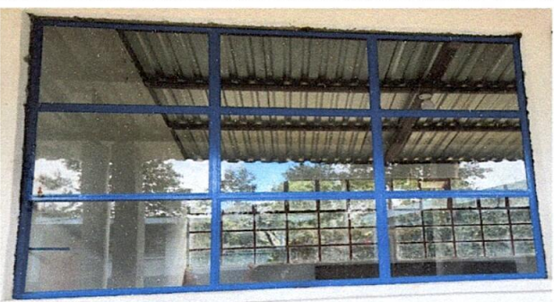
Foto 4: Sustitución de estructura de metal de ventana
