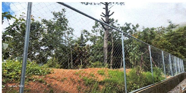
Foto 13: Reparación de tubo hg y malla galvanizada
