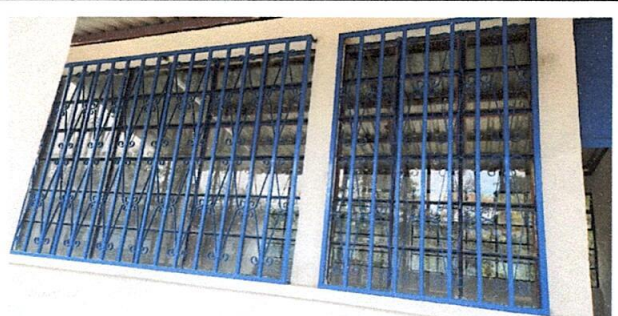
Foto 6: Sustitución de balcones de metal
