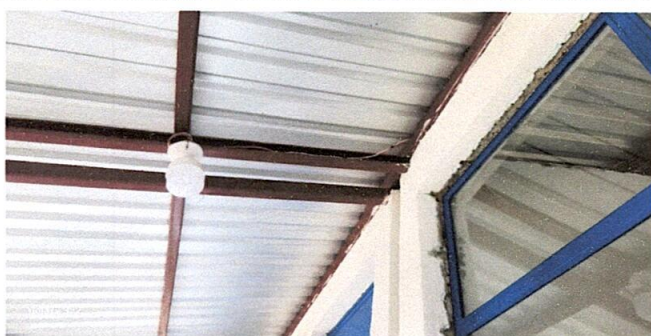
Foto 15: Reparación de cableado eléctrico
