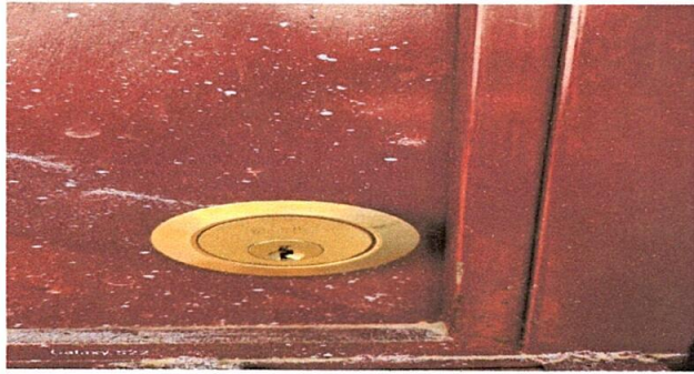
Foto1: Sustitución de chapa
