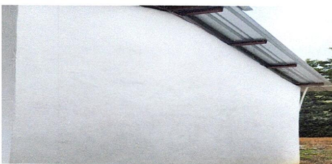
Foto 17: Repello en muro
