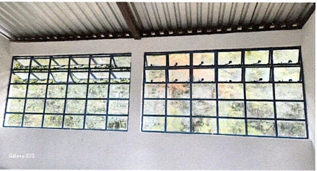
Foto 3: Mantenimiento a estructura de metal de ventana
