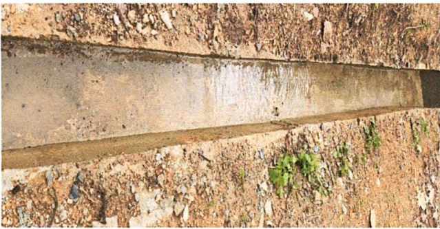
Foto 9: Reparación de cuneta de concreto
