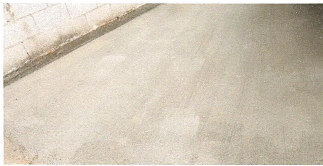
Foto 7: Sustrucción de piso de torta de concreto
