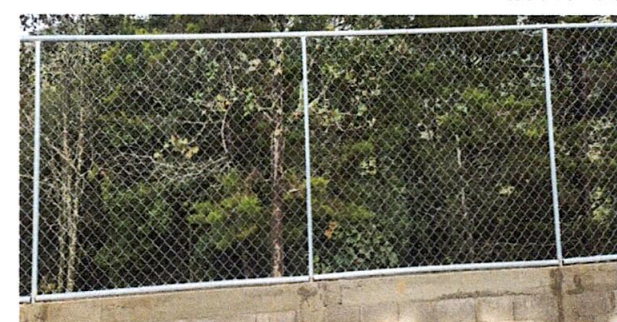
Foto 18: Reparación de tubo hg y malla galvanizada
