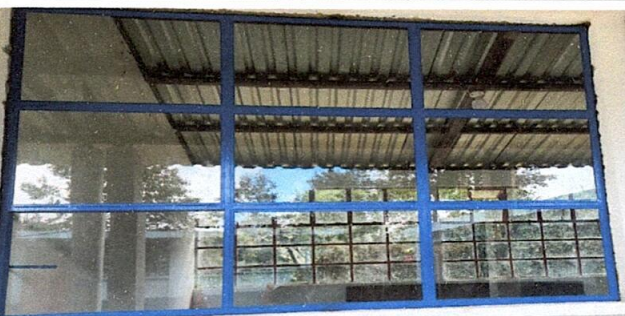
Foto 5: Sustitución de vidrios
