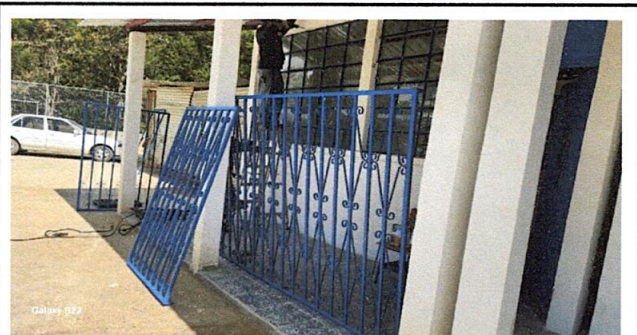
Foto 6: Sustrucción de balcones de metal
