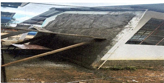
Foto 17: Repello en muro
