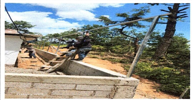
Foto 18: Reparación de tubo hg y malla galvanizada
