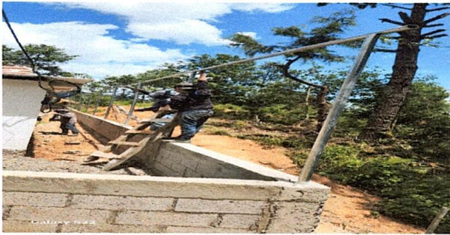
Foto 13: Reparación de tubo hg y malla galvanizada
