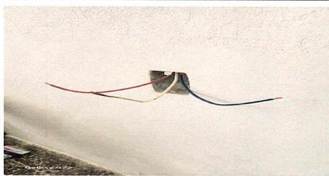
Foto 15: Reparación de cableado eléctrico
