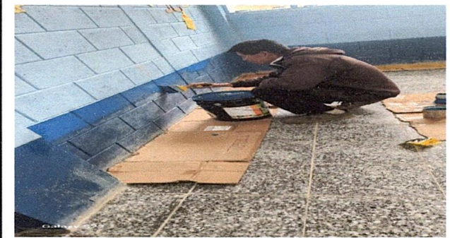
Foto 10: Pintura en muros exteriores e interiores
