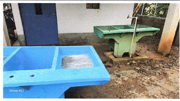
Foto 16: Sustitución de pila de cemento de dos lavadero
