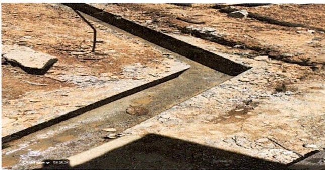
Foto 9: Reparación de cuneta de concreto
