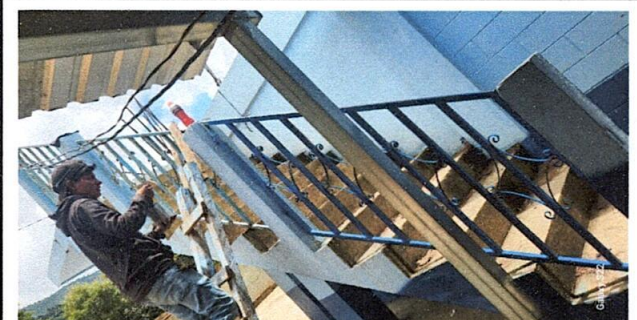
Foto 12: Mantenimiento a barandas de metal
