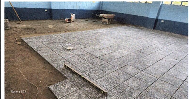
Foto 8: Sustitución de piso de granito
