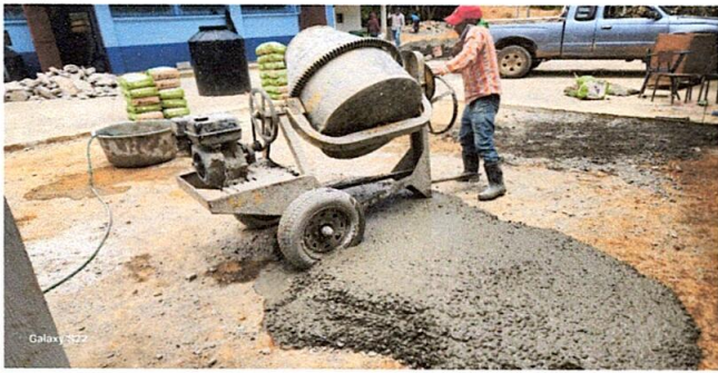
Foto 7: Sustitución de piso de torta de concreto
