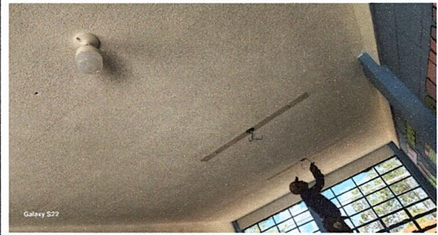
Foto 14: Sustitución de focos ahorradores
