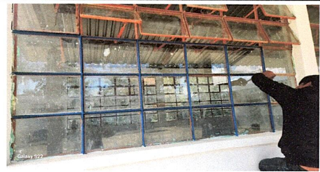
Foto 3: Mantenimiento a estructura de metal de ventana
