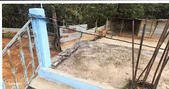
Foto 12: Mantenimiento a barandas de metal
