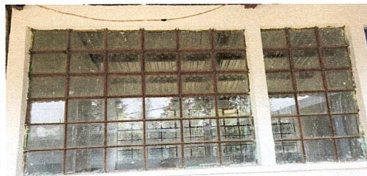
Foto 4: Sustrucción de estructura de metal de ventana
