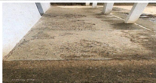
Foto 7: Sustitución de piso de torta de concreto
