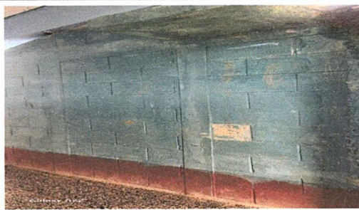
Foto 10: Pintura en muros exteriores e interiores
