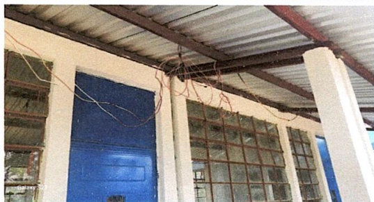
Foto 15: Reparación de cableado eléctrico
