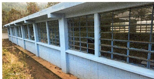
Foto 5: Sustrucción de vidrios
