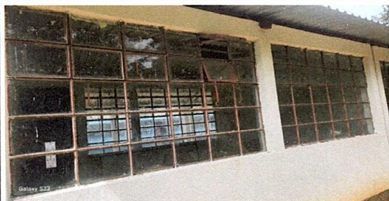
Foto 3: Mantenimiento a estructura de metal de ventana
