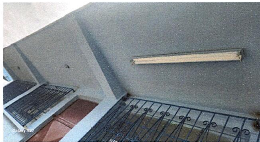
Foto 14: Sustitución de focos ahorradores
