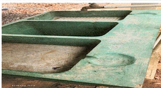
Foto 16: Sustitución de pila de cemento de dos lavadero
