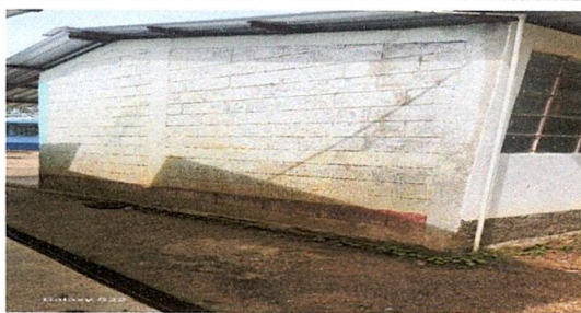
Foto 17: Repello en muro
