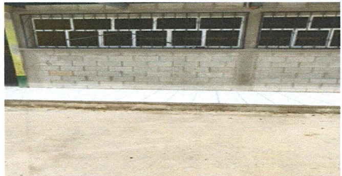
Foto 4: Mejoramiento y finalización de ventanas y balcones
