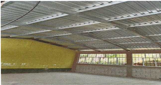
Foto 3: Implementación y finalización de piso
