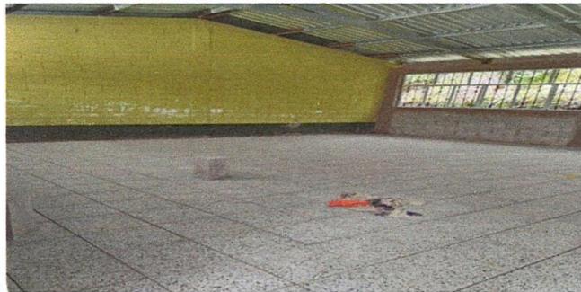
Foto 5: Mejoamiento y finalización de piso de aula
