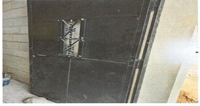
Foto 2: Mejoramiento de puerta de metal
