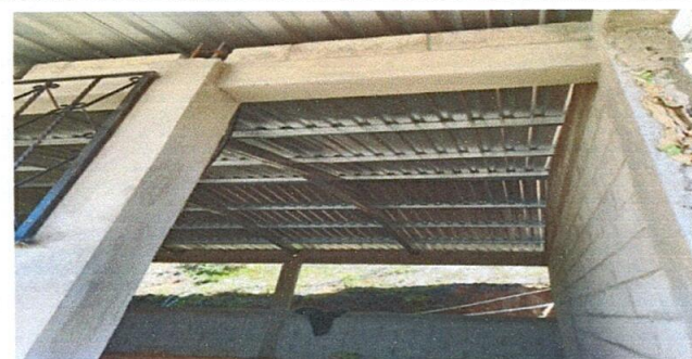
Foto 6: Mejoramiento de puesta techo y balcones.
