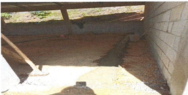
Foto 4: Mejoramiento de piso
