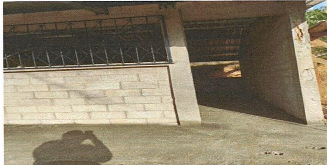
Foto 2: Mejoramiento de balcones
