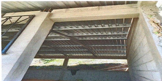
Foto1: Mejoramiento con estructura de techo
