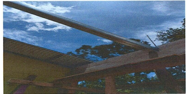
Foto 4: Colocación de estructura portante de metal
