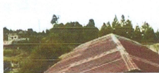
Foto 6: Sustitución de techo
