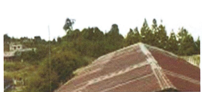
Foto 6: Sustitución de techo
