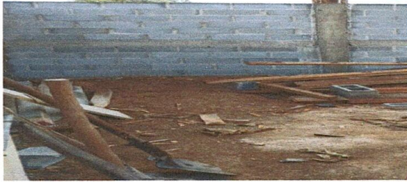
Foto1: Mejoramiento con estructura de techo
