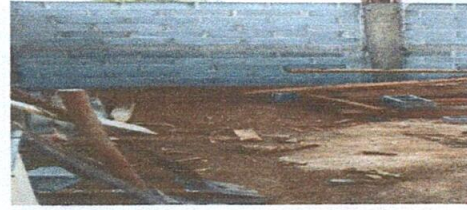
Foto 2: Mejoramiento con piso de torta de concreto
