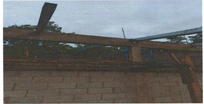
Foto 2: Mejoramiento de estructura poortante de metal
