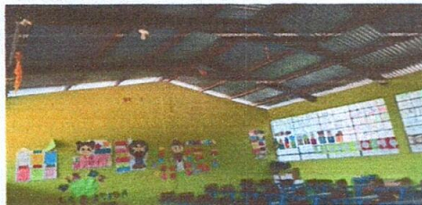
Foto 5: Reparación de sistema eléctrico
