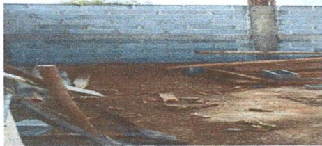
Foto 1: Mejoramiento con estructura de techo
