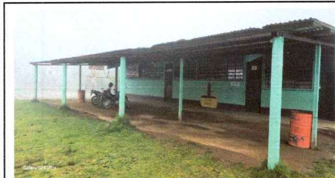
Foto 1: Sustrucción de techo y piso de cemento de torta
