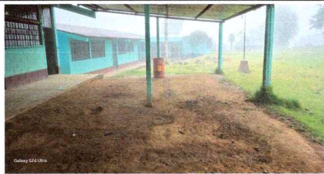
Foto 4: Sustrucción de torta de concreto
