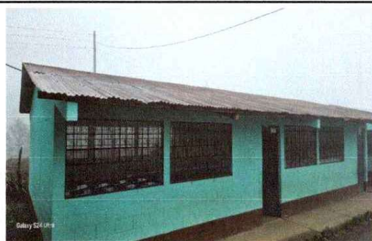
Foto 2: Sustrucción de techo de lamina por lamina Troqueladacalibre 26 y sustitucion de fijacion capote por capote de metal.
