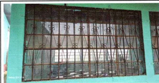
Foto 5: Mantenimiento de Balcones de metal lijado y pintado con pintura anticorrosiva
