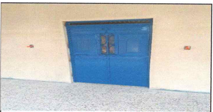
FOTO 5. REPARACION DE REPELLO
