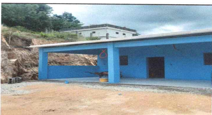
FOTO 4. SUSTITUCION DE PISO DE GRANITO
