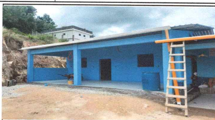
FOTO 2. CANALES Y BAJADAS DE AGUA PLUVIAL
