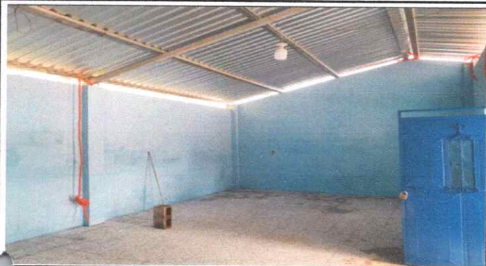
FOTO 1. CUBIERTA DE LAMINA
