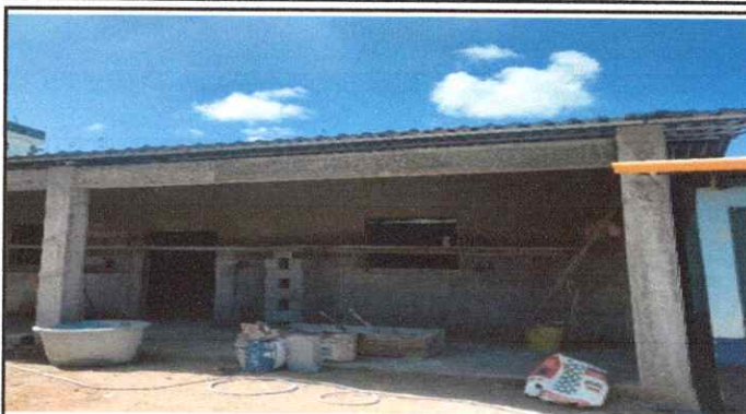
FOTO 2. CANALES Y BAJADAS DE AGUA PLUVIAL
