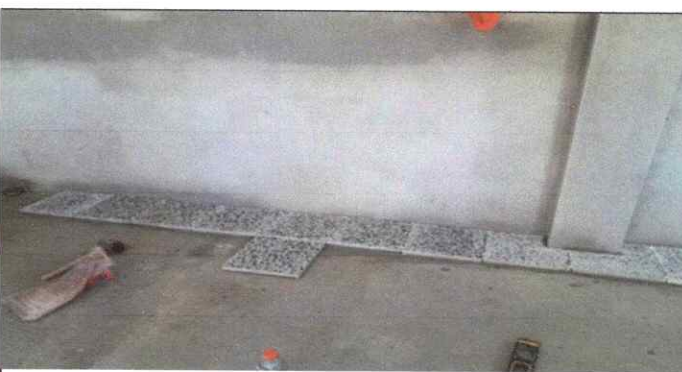
FOTO 4. SUSTITUCION DE PISO DE GRANITO
