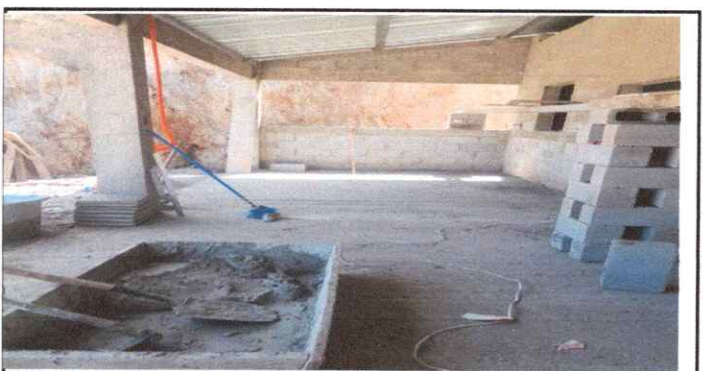
FOTO 5. REPARACION DE REPELLO
