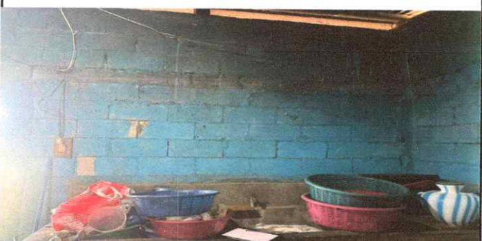
FOTO 3. REPARACION DE COCINA
