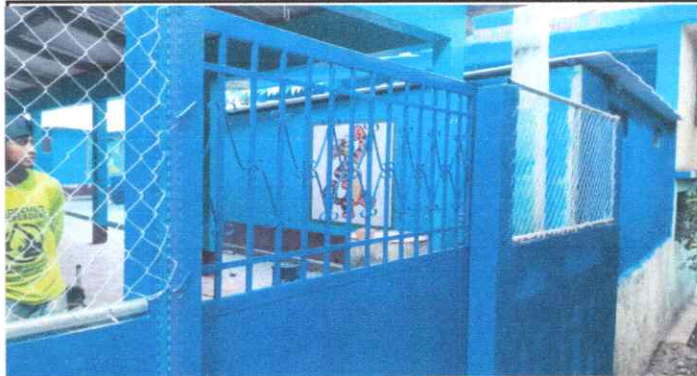
Foto 2: Sustitución de portón de metal por 1.85 por 2 metros
