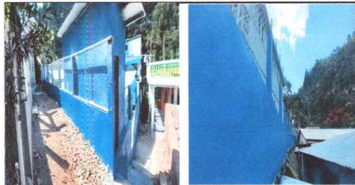
Foto 6: Pintura de muros exteriores e interiores
