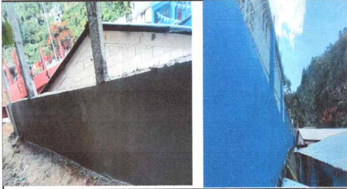
Foto 1: Repello en muro
