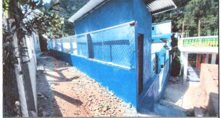
Foto 2: Sustitución de tubo hg y malla galvanizada
