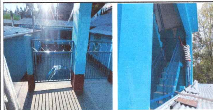
Foto 5: Sustitución de barandas de metal
