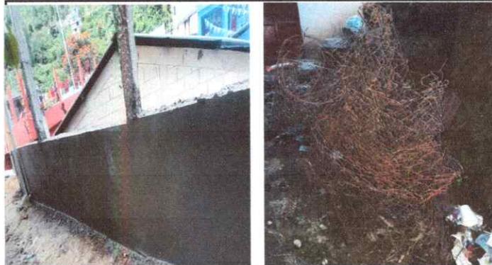
Foto 2: Sustitución de tubo hg y malla galvanizada
