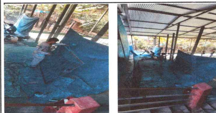
Foto 5: Sustitución de barandas de metal
