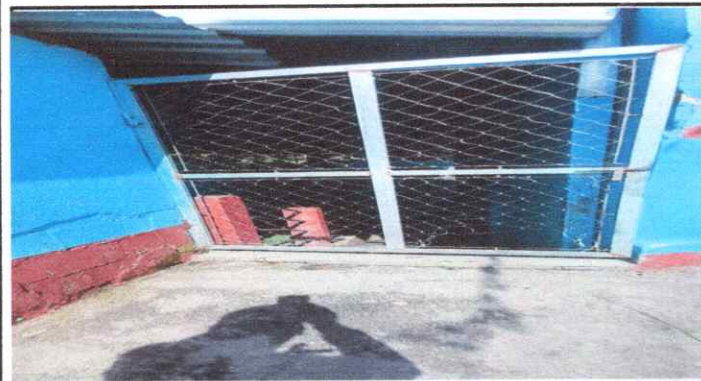
Foto 3: Sustitución de metal de 1.29 por 1.95 metros
