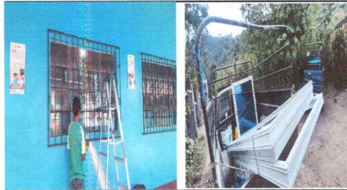
Foto 4: Mantenimiento a balcones de metal. Sustitución de ventanas de metal por ventanas de PVC más vidrio
