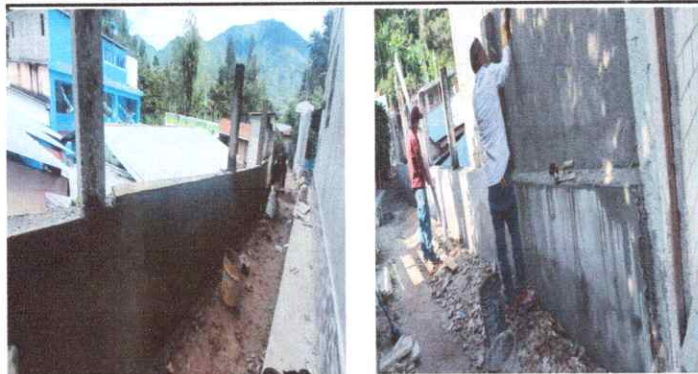
Foto1: Repello en muro
