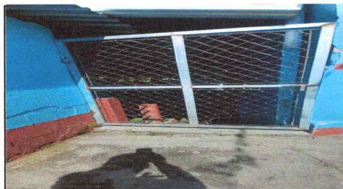
FOTO 3: sustitución de portón de metal de 1.29 por 1.95 metros
