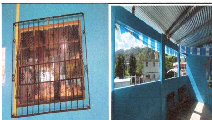
FOTO 4: mantenimiento a balcones de metal. Sustitución de ventanas de metal por ventanas de PVC más vidrio
