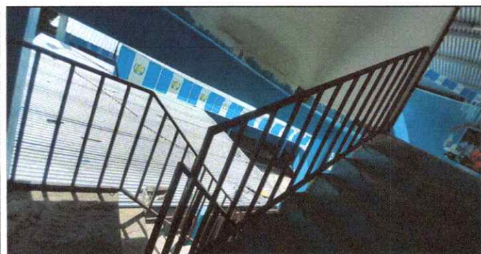
FOTO 4: Sustitución de barandas de metal
