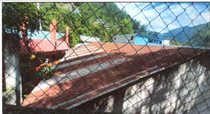
FOTO1: Sustitución de techo de lámina, por lámina troquelada calibre 26
