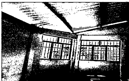
Foto 3: Sustrucción de estructura de metal de ventana modulo 1 segundo nivel modulo 2 primer y segundo nivel.
