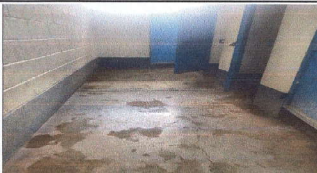
Foto 2: Reparación de piso de torta concreto
