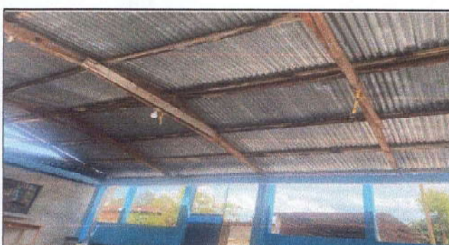
Foto 4: sustitución de láminas por lámina troquelada Aluzinc calibre 26
