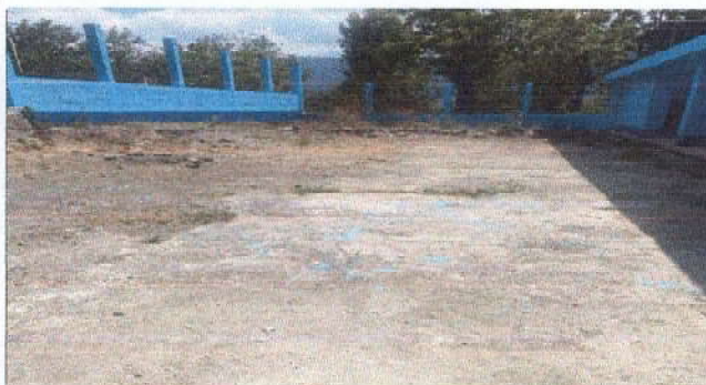
Foto 3: Reparación de piso de torta a concreto
