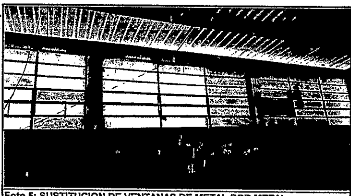
Foto 5: SUSTITUCION DE VENTANAS DE METAL POR METAL
