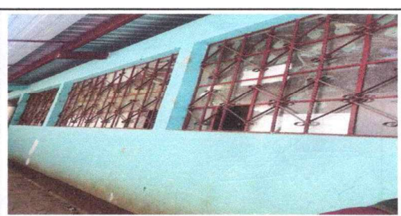
INSTALACIÓN DE BALCONES DE METAL
