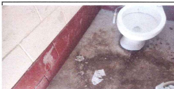
COLOCACIÓN DE AZULEJO Y PISO ANTIDESLIZANTE
