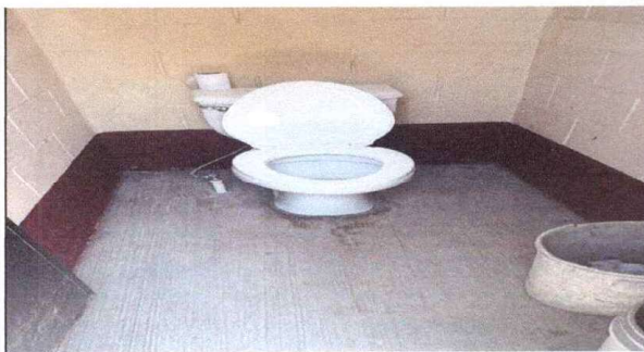
SUSTITUCIÓN DE SANITARIOS
