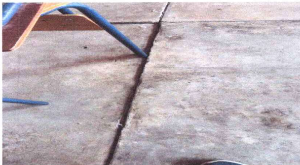
SUSTITUCIÓN DE PISO
