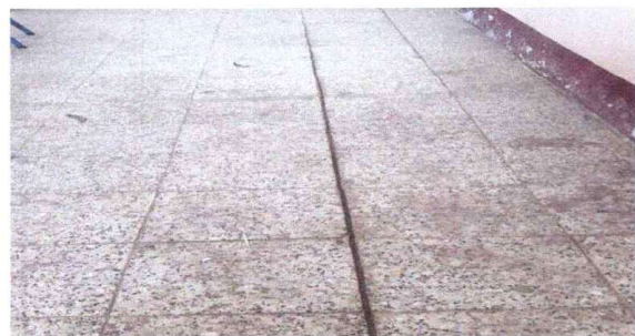
SUSTITUCIÓN DE PISO GRANITO
