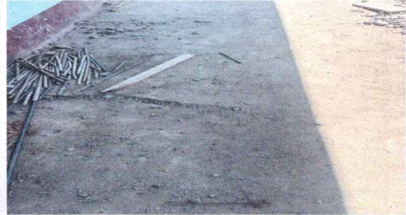
REPARACIÓN DE LOSA DE PATIO
