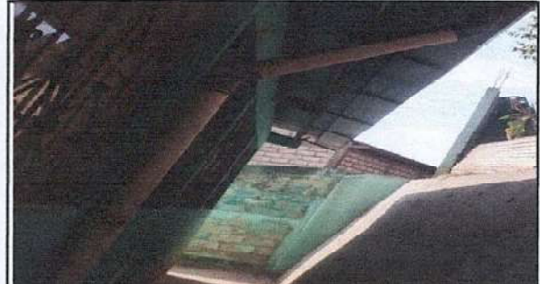
SUSTITUCION DE CANAL
