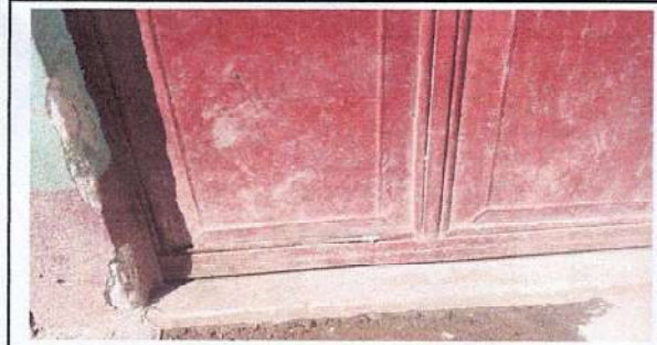
SUSTITUCIÓN DE PUERTAS DE METAL
