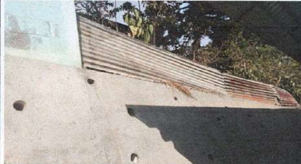
REPARACION DE MURO PERIMETRAL
