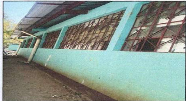
PINTURA EN MUROS EXTERIORES E INTERIORES
