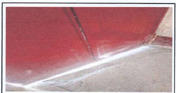
SUSTITUCIÓN DE PUERTAS DE METAL
