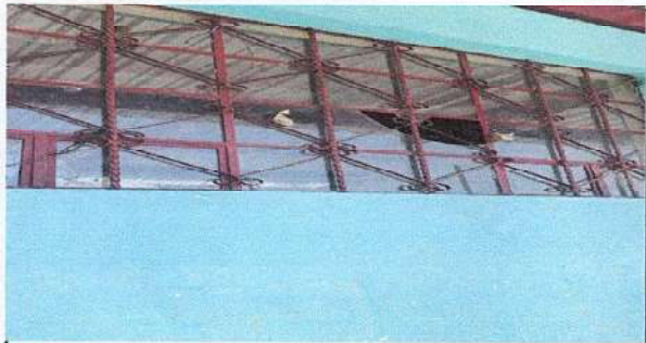
SUSTITUCIÓN DE VENTANAS
