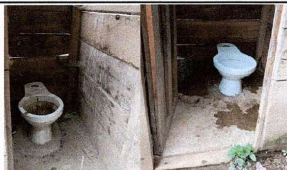
Foto 12: Sustitución de Inodoros
