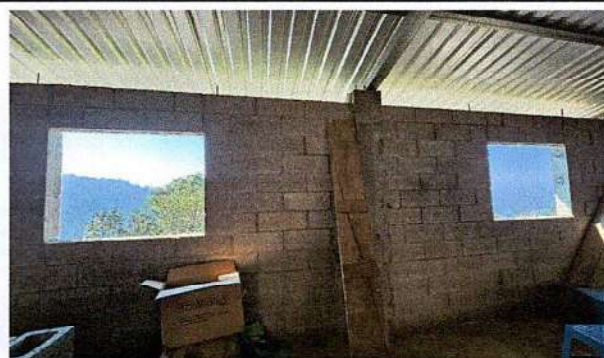
Foto 8: Mejoramiento de Ventanas de Metal y Balcones
