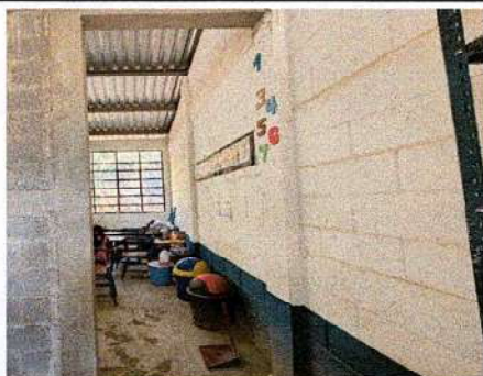
Foto 11: Mejoramiento Puerta de Metal
