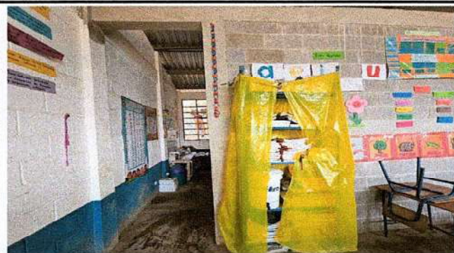
Foto 10: Mejoramiento Puerta de Metal
