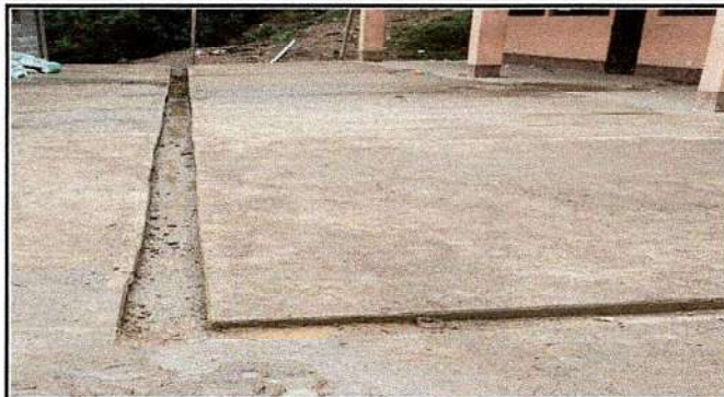
Foto 2: Mejoramiento de Rejilla de Patio
