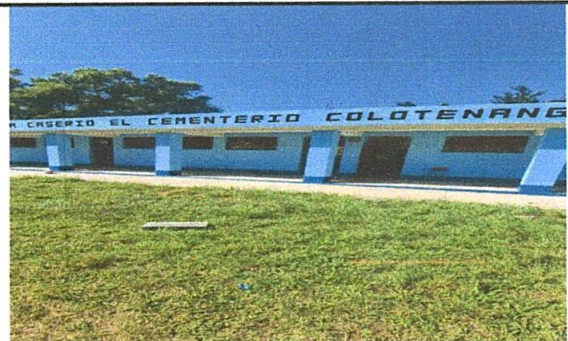
Foto 6: Finalización de pintura
