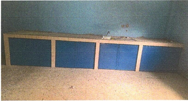
Foto 1: Finalización de mesa de concreto, lavatrastes con puertas
