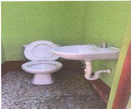
Foto 3: Finalización de inodoro y accesorios
