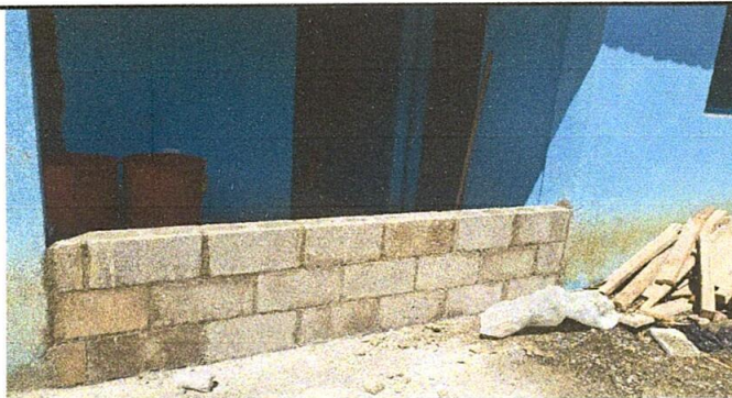
Foto 5: Inicio de muro
