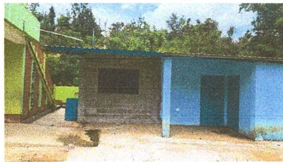
Foto 4: Sustitución de canal de pvc
