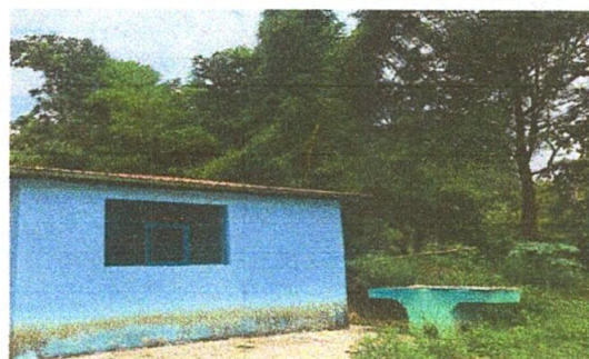
Foto 2: Sustitución de balcones de metal
