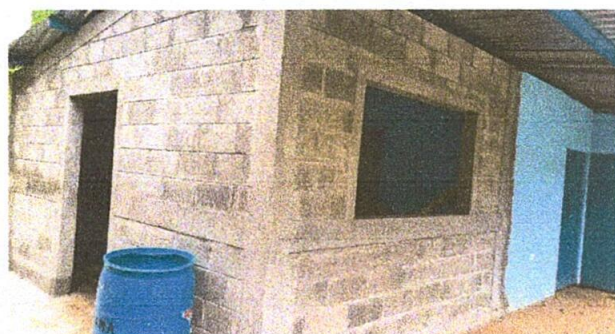
Foto 3: Sustitución de puerta (2.10m de alto * 1.00m de ancho)
