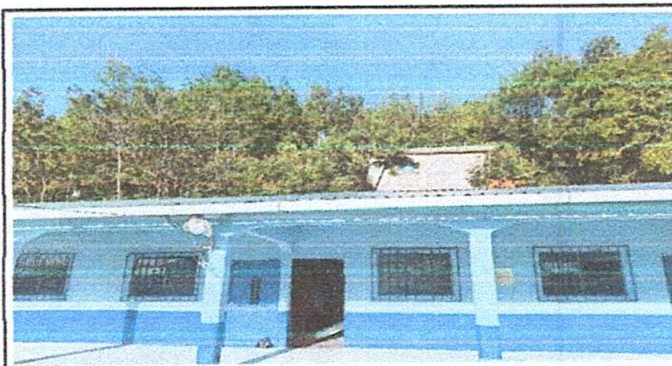
Foto 3: pintura en paredes
