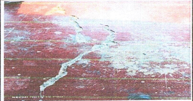
FOTO 2: Sustitución de piso por piso granito
