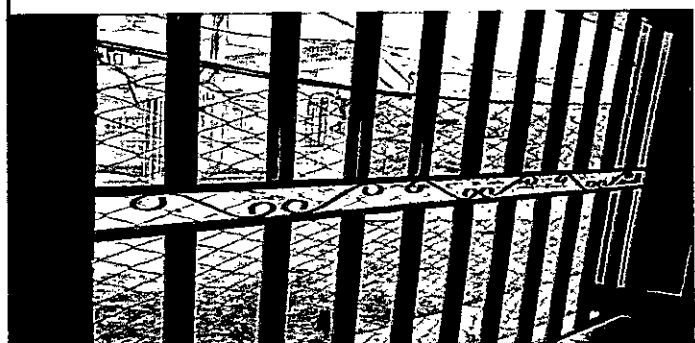
FOTO 9: Sustitución de baranda de metal
