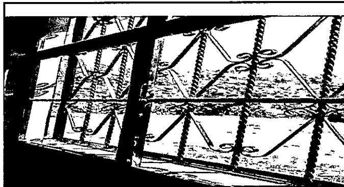
FOTO 4: Sustitución de ventanas de metal
