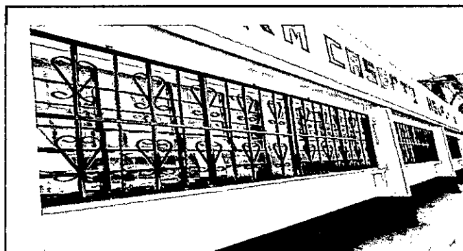
FOTO 6: Sustitución de balcones de metal
